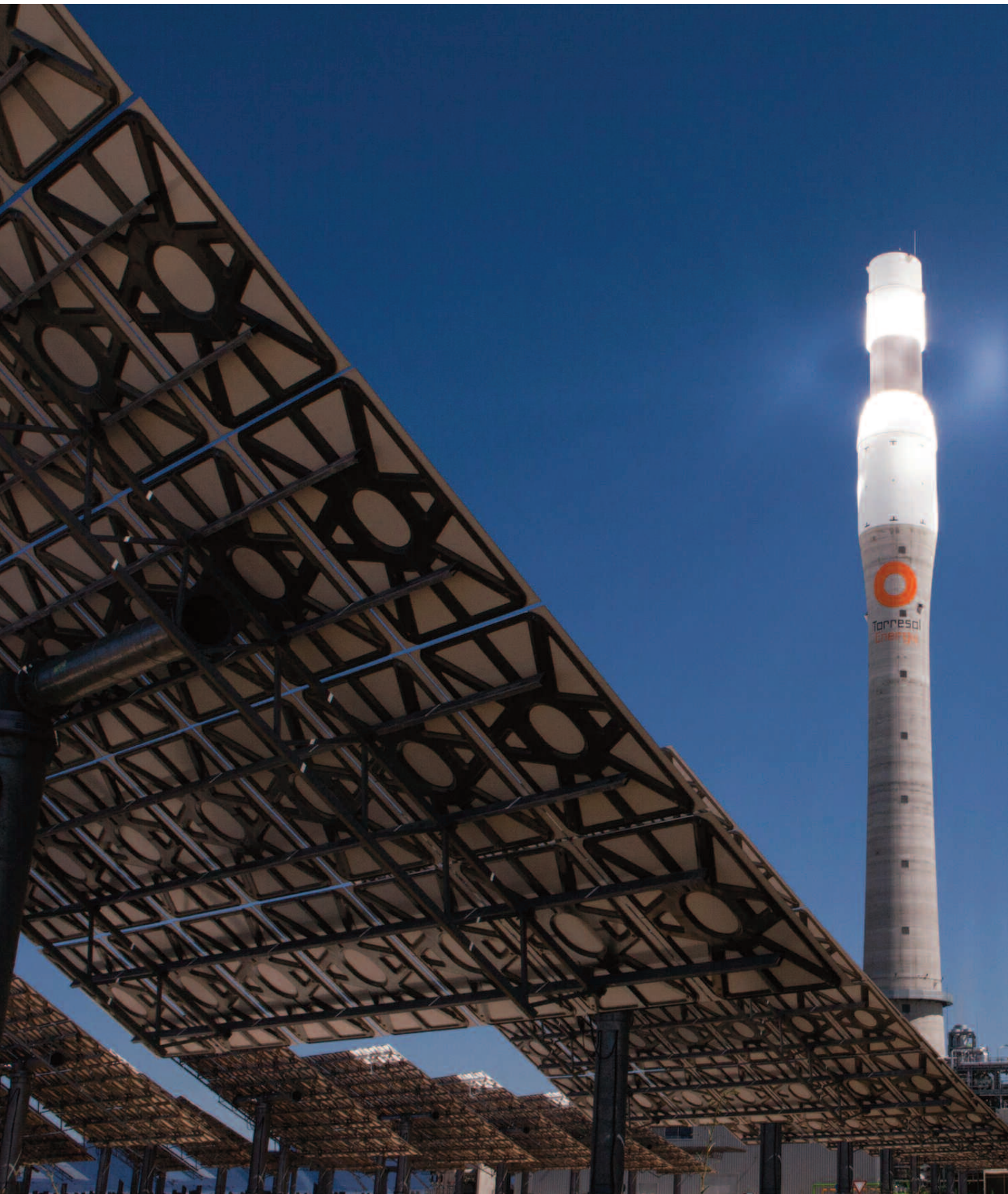
Planta solar térmica Gemasolar, propiedad de Torresol Energy. © Torresol Energy.
